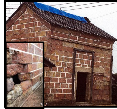
石蔵 改修工事
