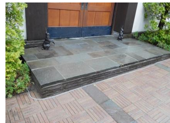
玄関小端石積・石貼
