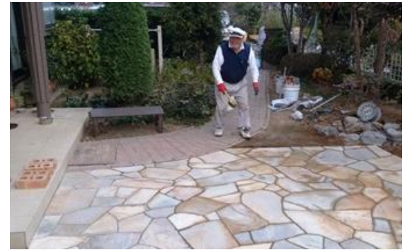
個人邸 石乱貼り工事
